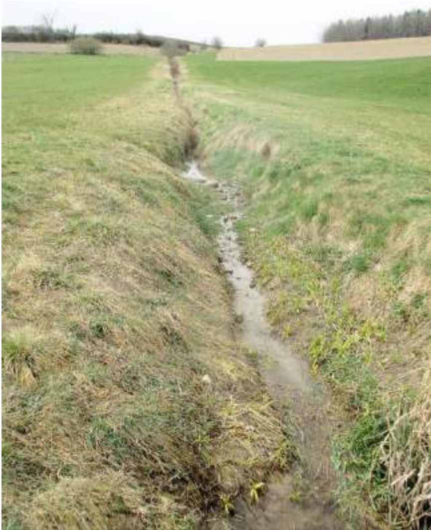
Am westlichen Plangebietsrand verläuft ein Entwässerungsgraben.
