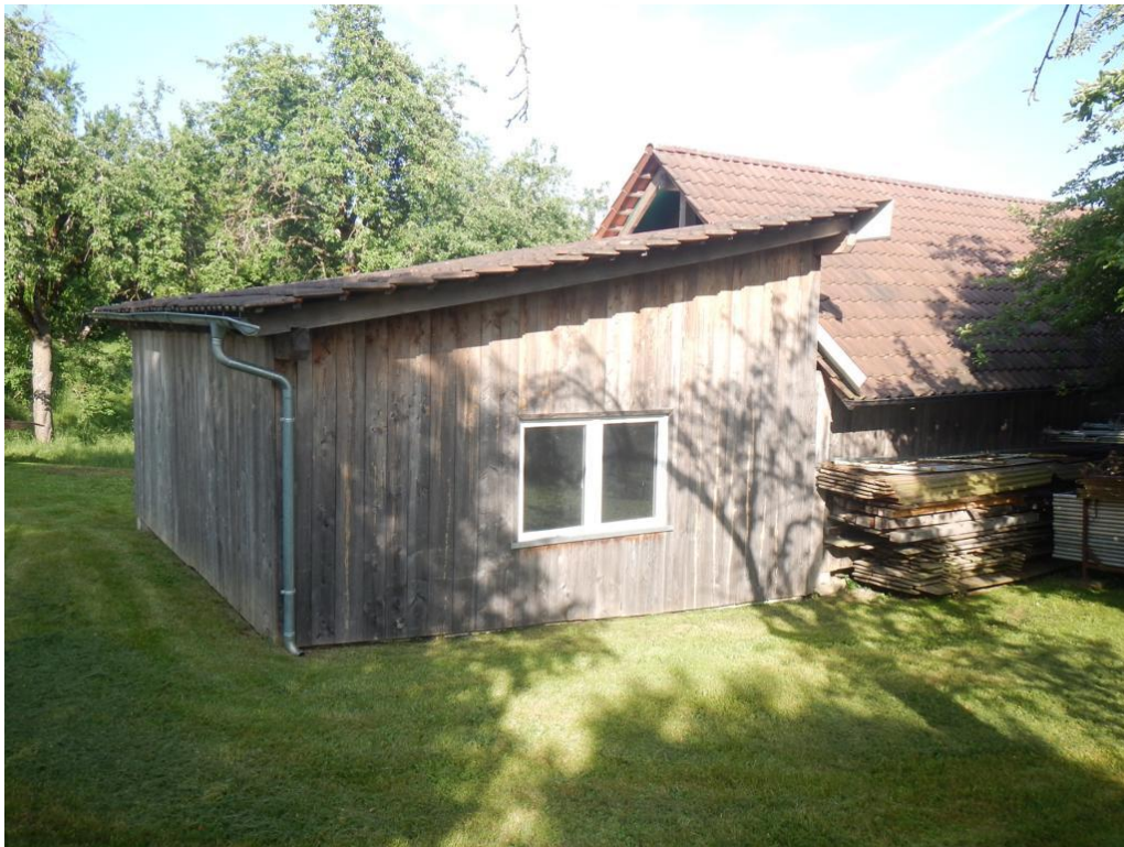
Bild 3: Blick nach Osten, vorhandene Gebäude und Garten als Rasenfläche. (2506127645.JPG)
