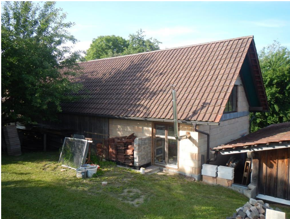
Bild 5: Blick nach Nordwesten, Gebäude mit Rasenfläche. (2506127653.JPG)
